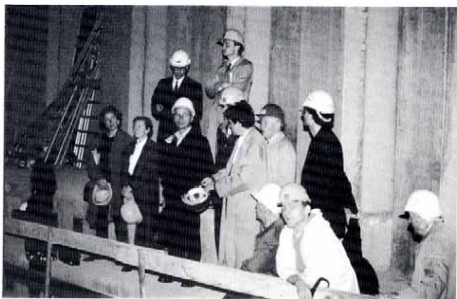
Des visites de chantiers sont organisées à l'occasion de la journée de la SFA ; ici il s'agit de la visite de la cité de la musique de La Villette conçue par Portzamparc.
